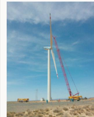
4月18日，公司马鬃山第二风电场A区200MW项目首台1.5MW风机成功吊装，标志着肃北风电项目进入风机吊装建设阶段。该项目位于肃北蒙古族自治县马鬃山镇戈壁荒滩，装设东汽FD89B-1.5MW风电机组67台、FD108B-2.0MW风电机组50台，总容量200.5MW，总投资15.7亿元，项目于2013年3月30日开工建设。
