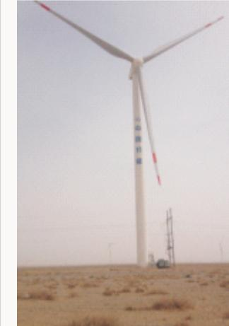
4月21日21时17分，公司哈密烟墩第五风电场项目首台风力发电机组并网成功，这是新疆风力工程建设史上首台2.5MW风力发电机组，首台机组的成功并网标志着首批5万kw容量并网发电调试工作全面展开。
